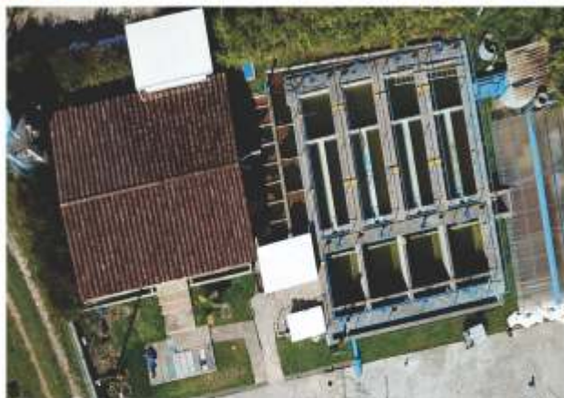
Planta de Tratamiento de Agua Potable
