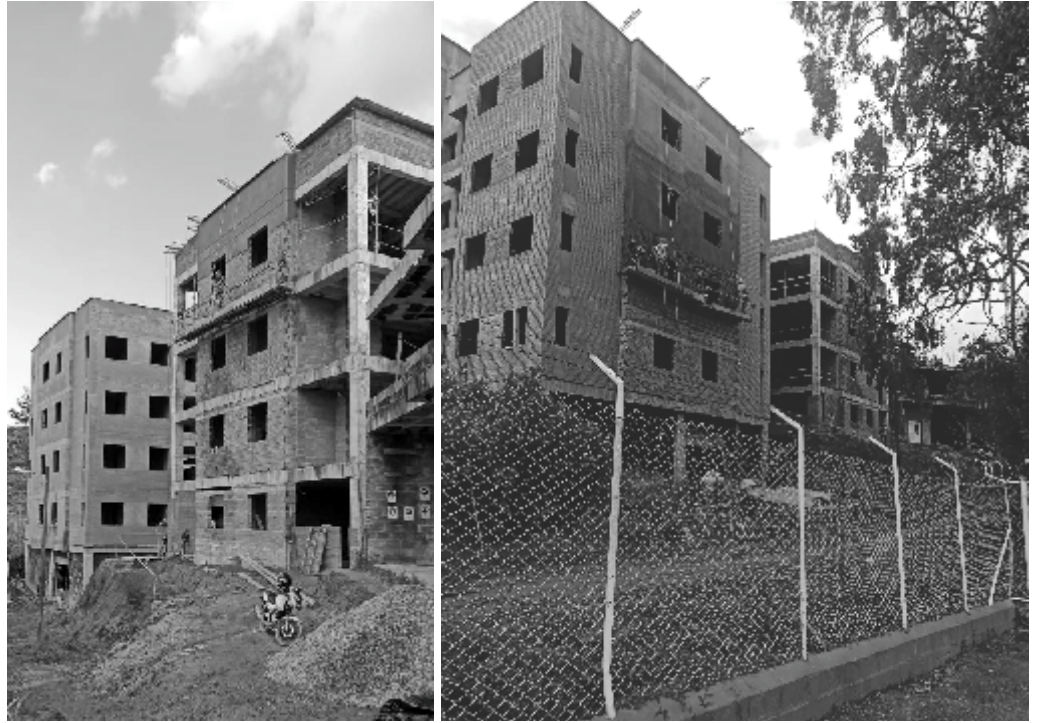
Imagen reciente de cómo va la construcción de Villa Alegría.
