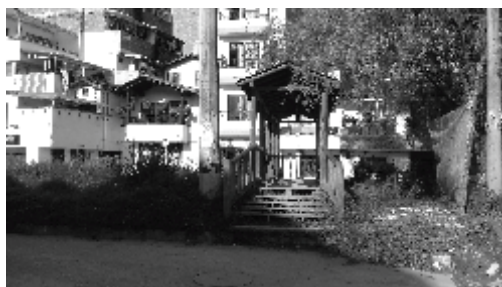
Vista frontal puente peatonal B. El Vergel
